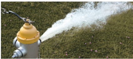
ÉTAPE 2 : PROVOQUEZ DES BRUITS DANS LA CANALISATION.
